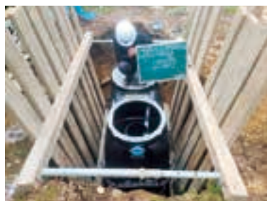
浄化槽設置②
