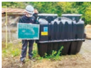
浄化槽設置①
