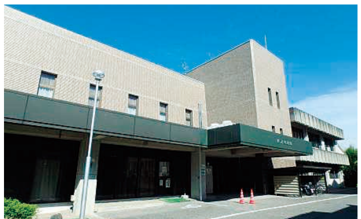
改修される久万町民館
