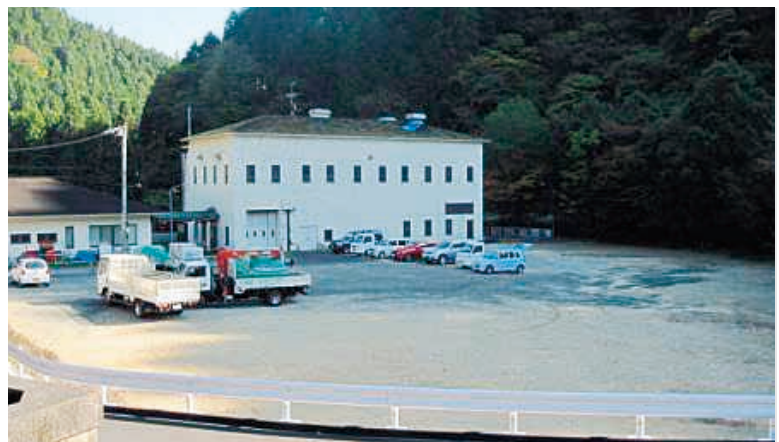
し尿処理施設全景
