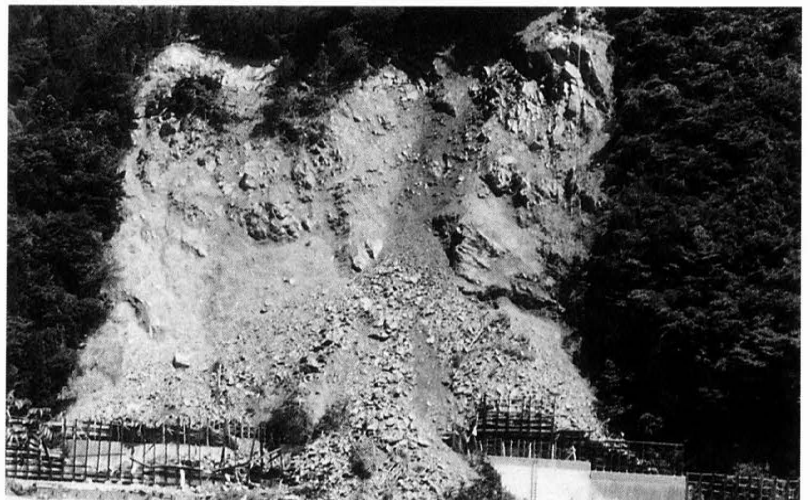
高知側斜面の岩塊が路面上に落下中 昭和54年7月20日
