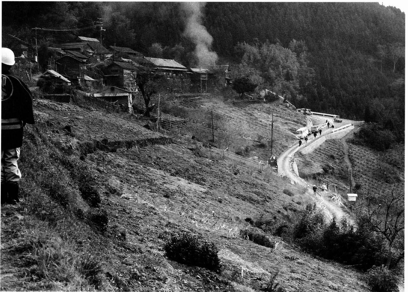
郷角住宅 2 棟全焼 昭和33年5月3日
