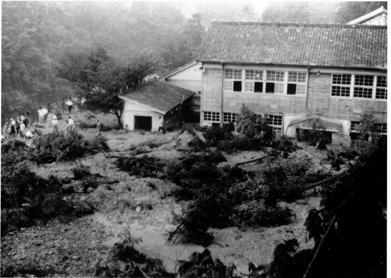
台風 9 号による柳谷中学校西谷分室崩壊 昭和38年8月9日
