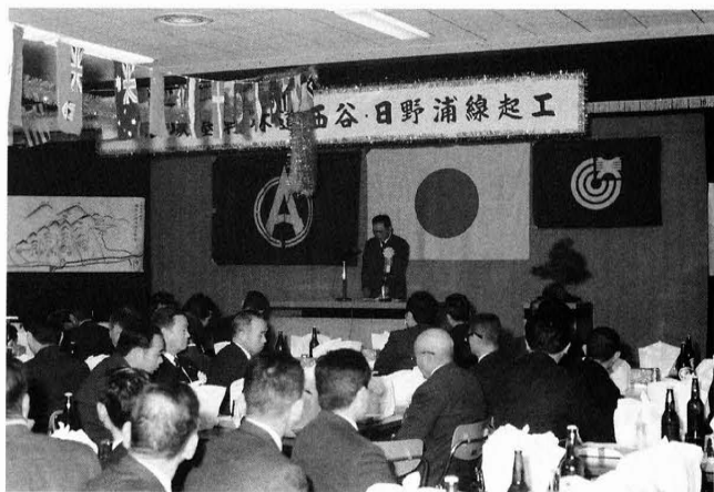
林道西谷日野浦線起工 昭和50年11月4日
