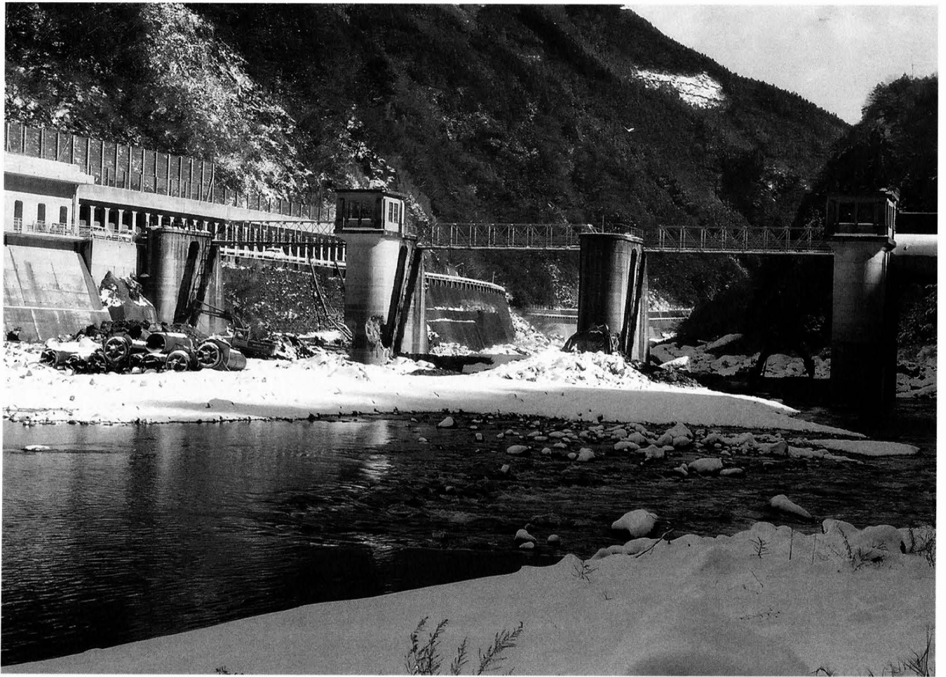
面河ダム取り壊し現場 昭和57年2月
