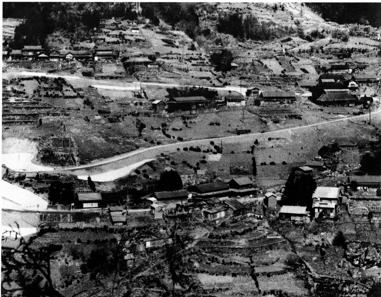
農道小村線起工 昭和48年8月5日
