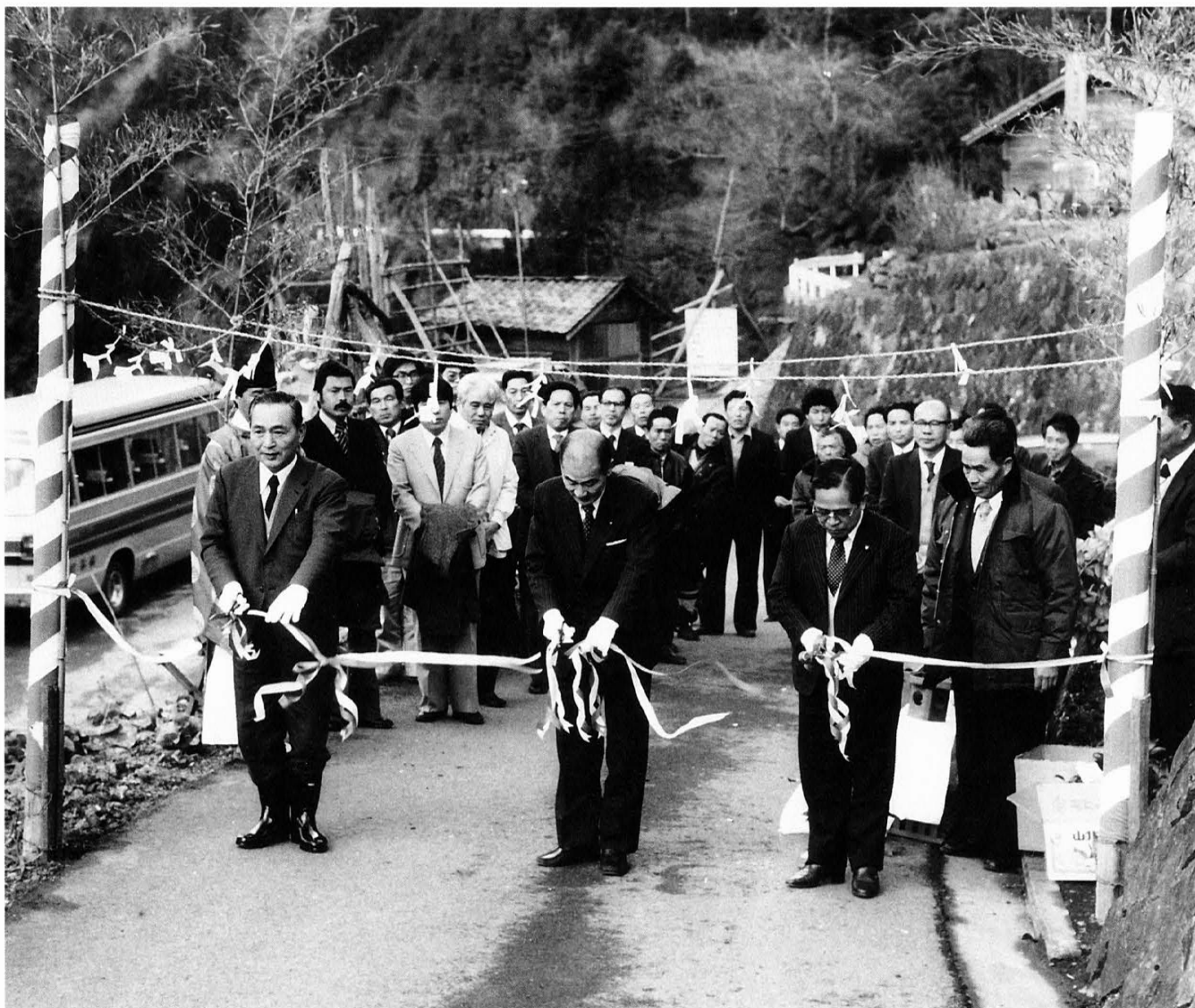
林道中畑線竣工 昭和39年12月13日
