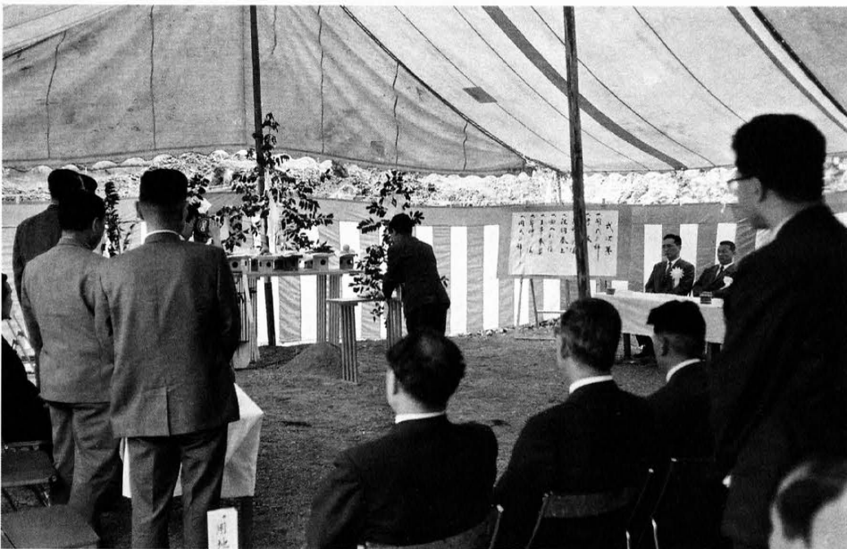
猪伏林道起工 昭和43年6月12日
