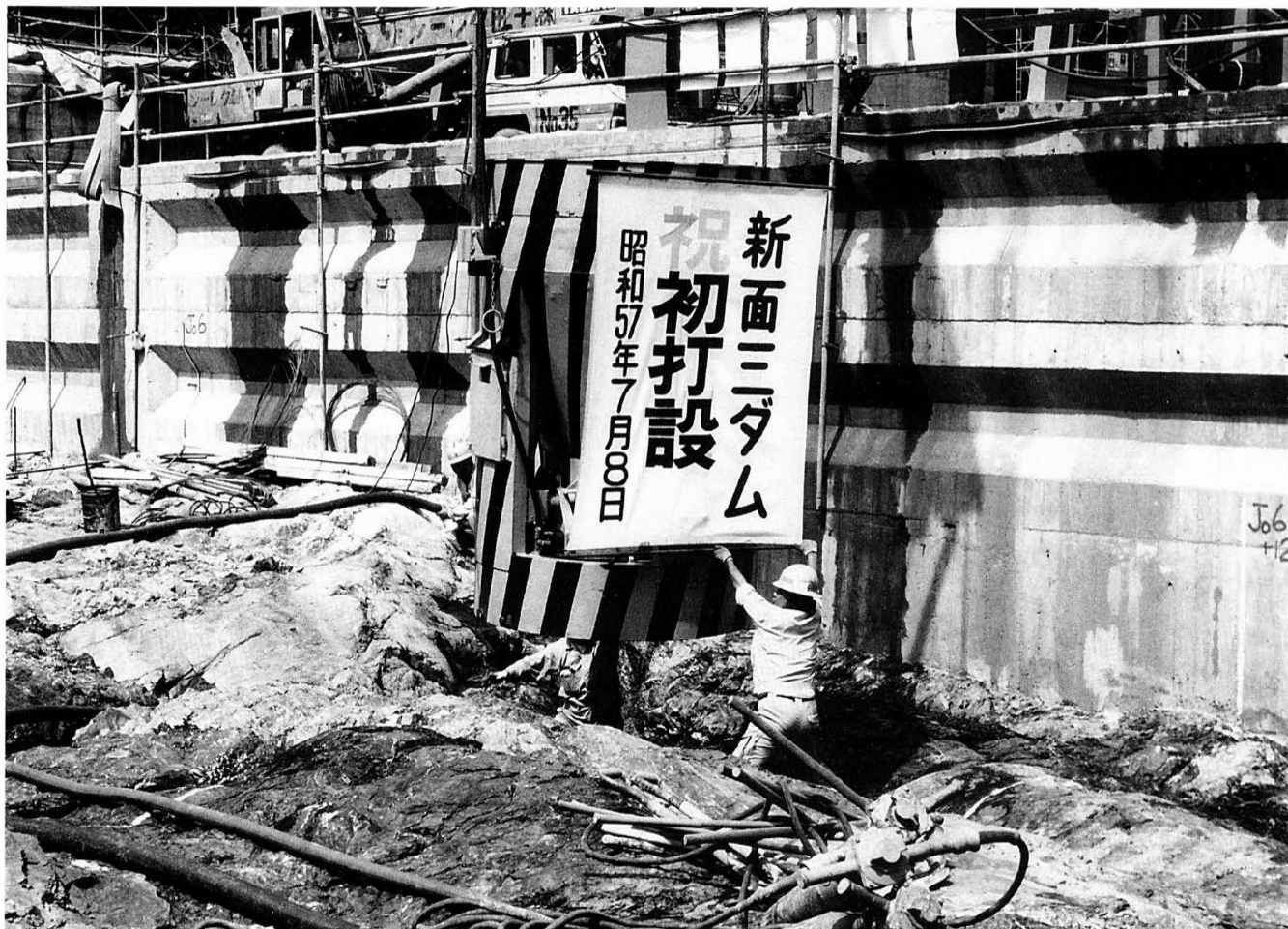
新面三ダムコンクリート打ち開始 昭和57年7月8日
