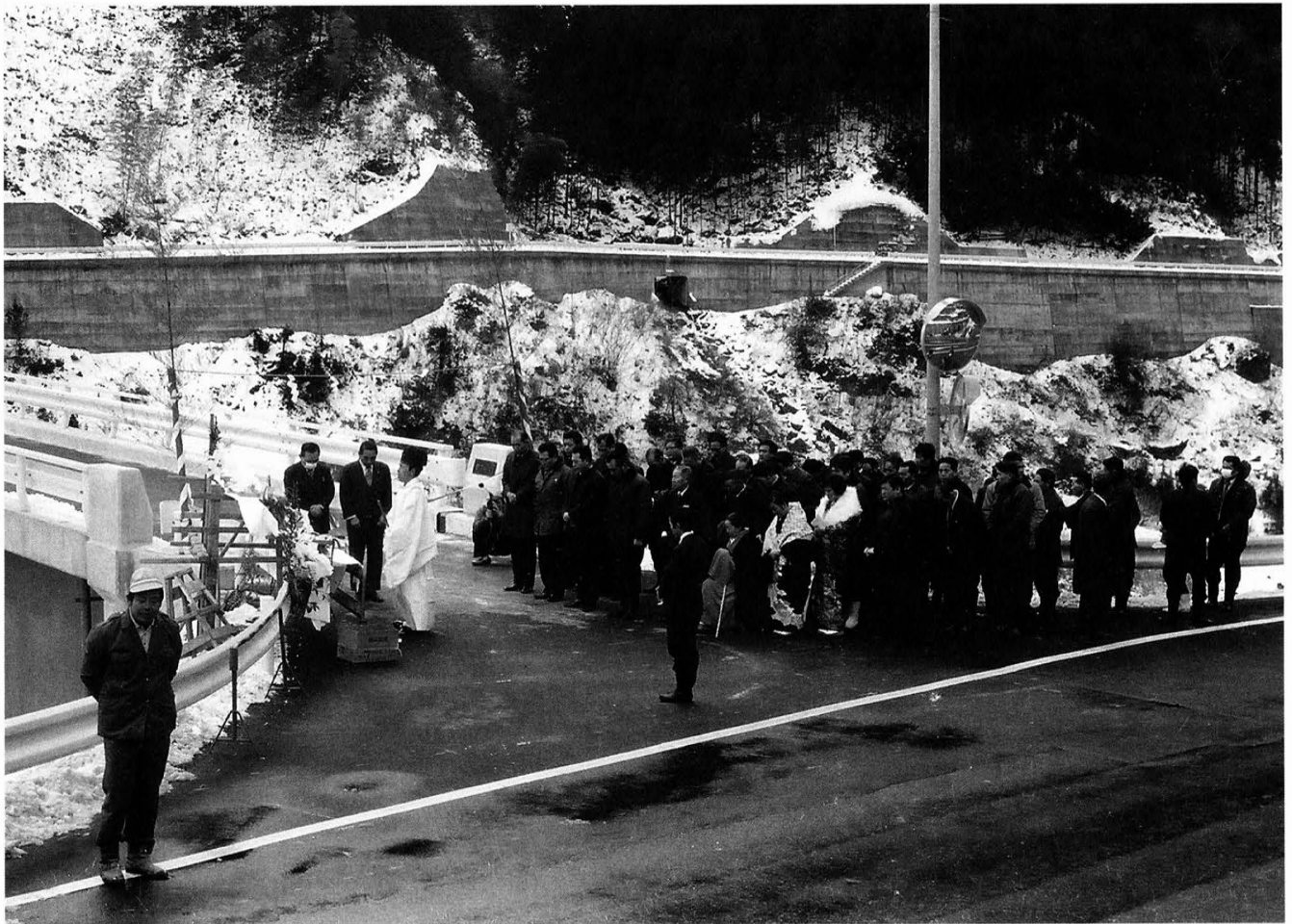
休場大橋竣工 昭和53年2月3日
