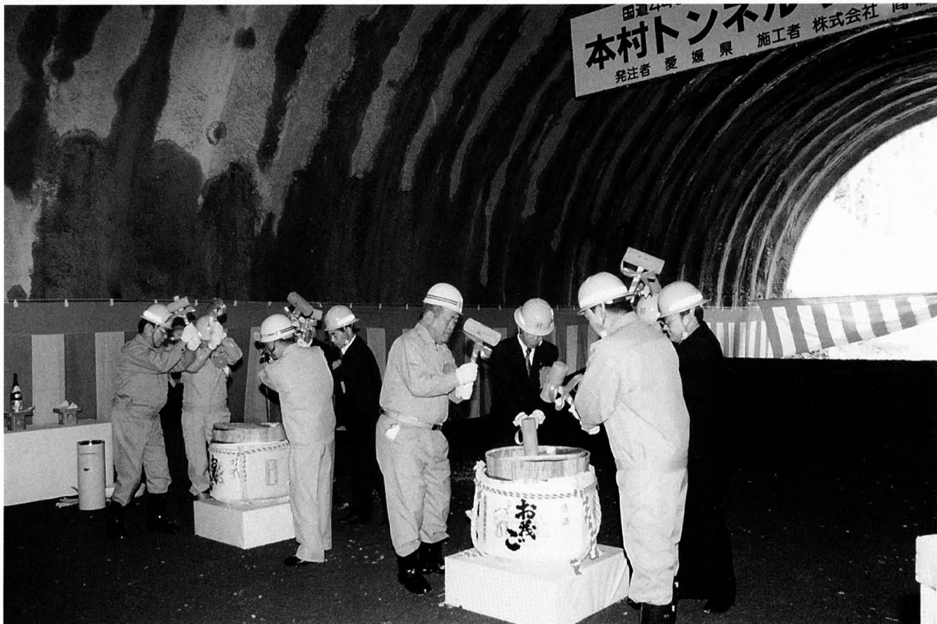
R440 落出バイパス本村トンネル貫通 平成9年2月7日
