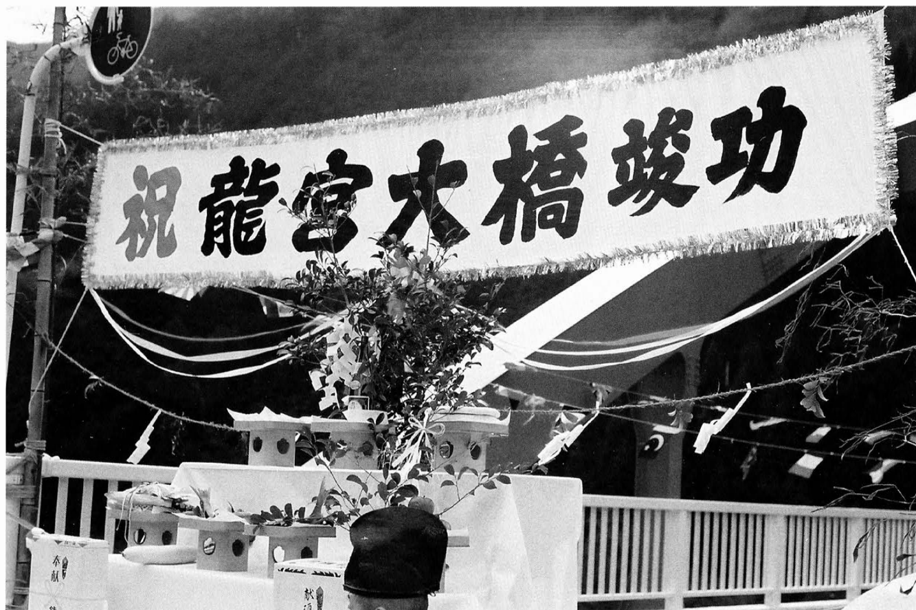
龍宮大橋竣工（田村家三世代夫婦渡り初め） 昭和54年1月24日
