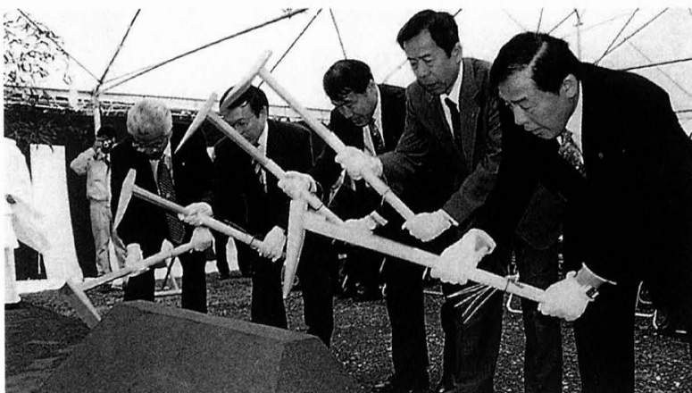
地芳トンネル起工式(横野) 平成12年4月23日
