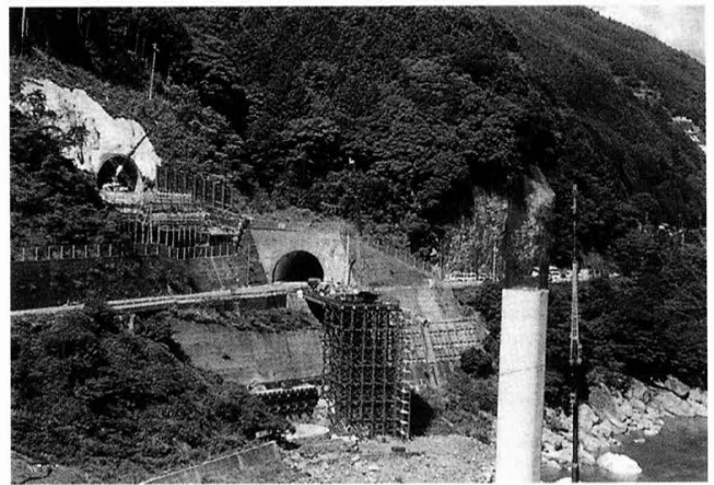
R440落出トンネル貫通 平成12年9月7日
