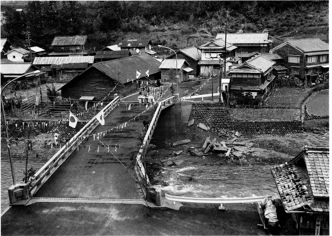
県道古味橋竣工 昭和43年3月21日
