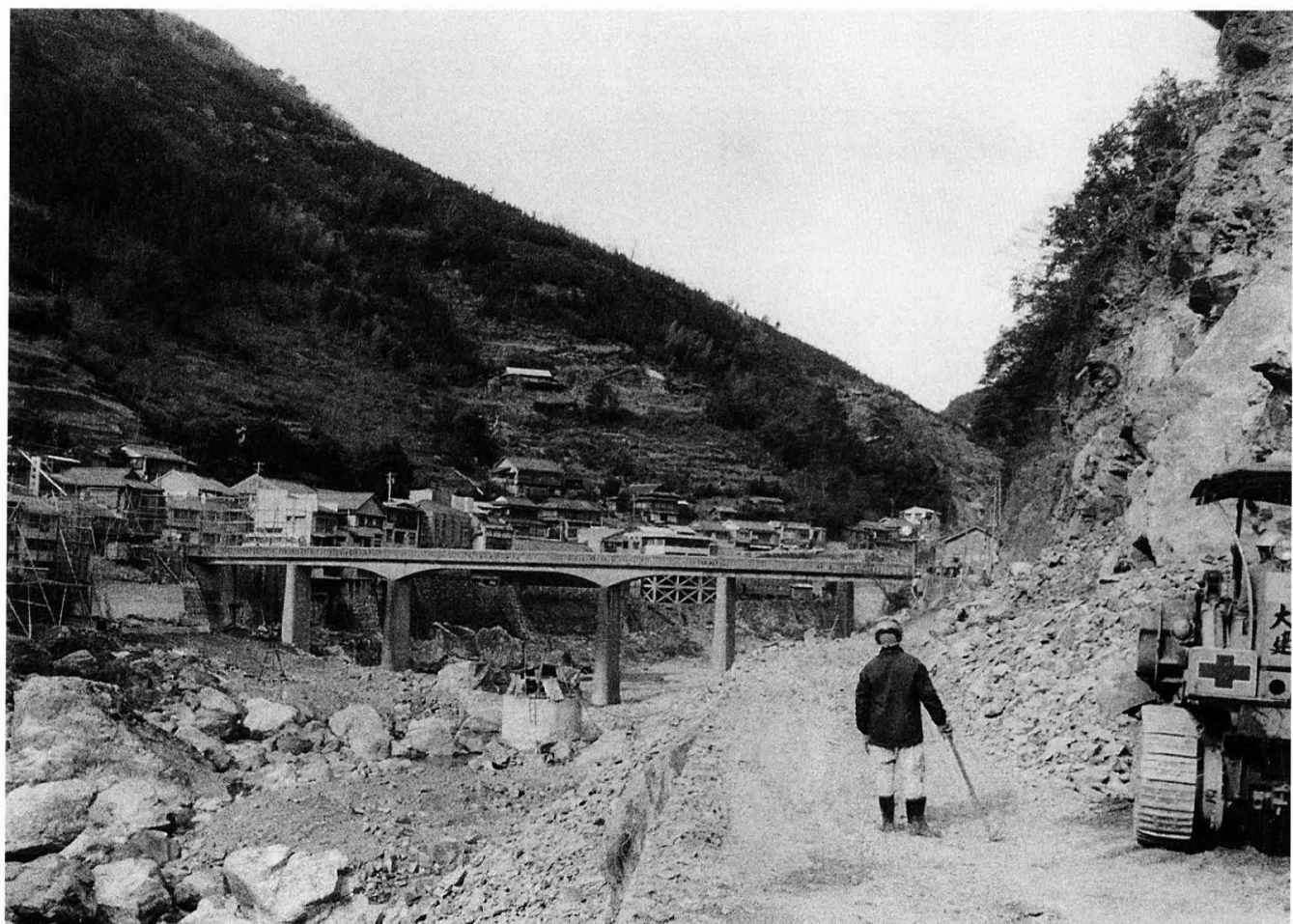
国道33号線 2車線改良工事 昭和42年8月5日
