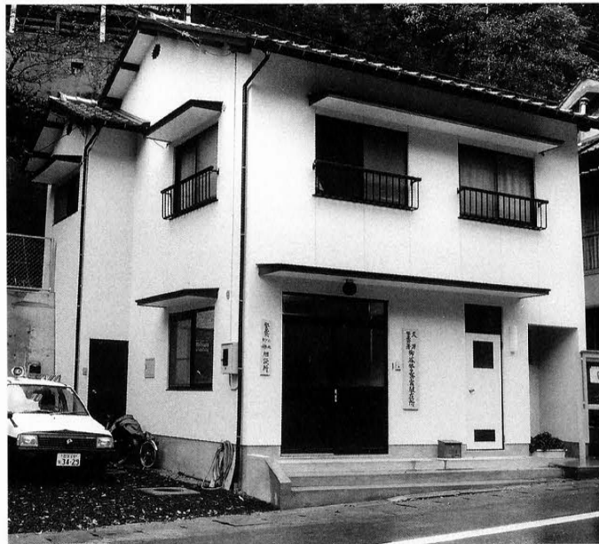
柳谷駐在所新築移転 昭和62年12月1日
