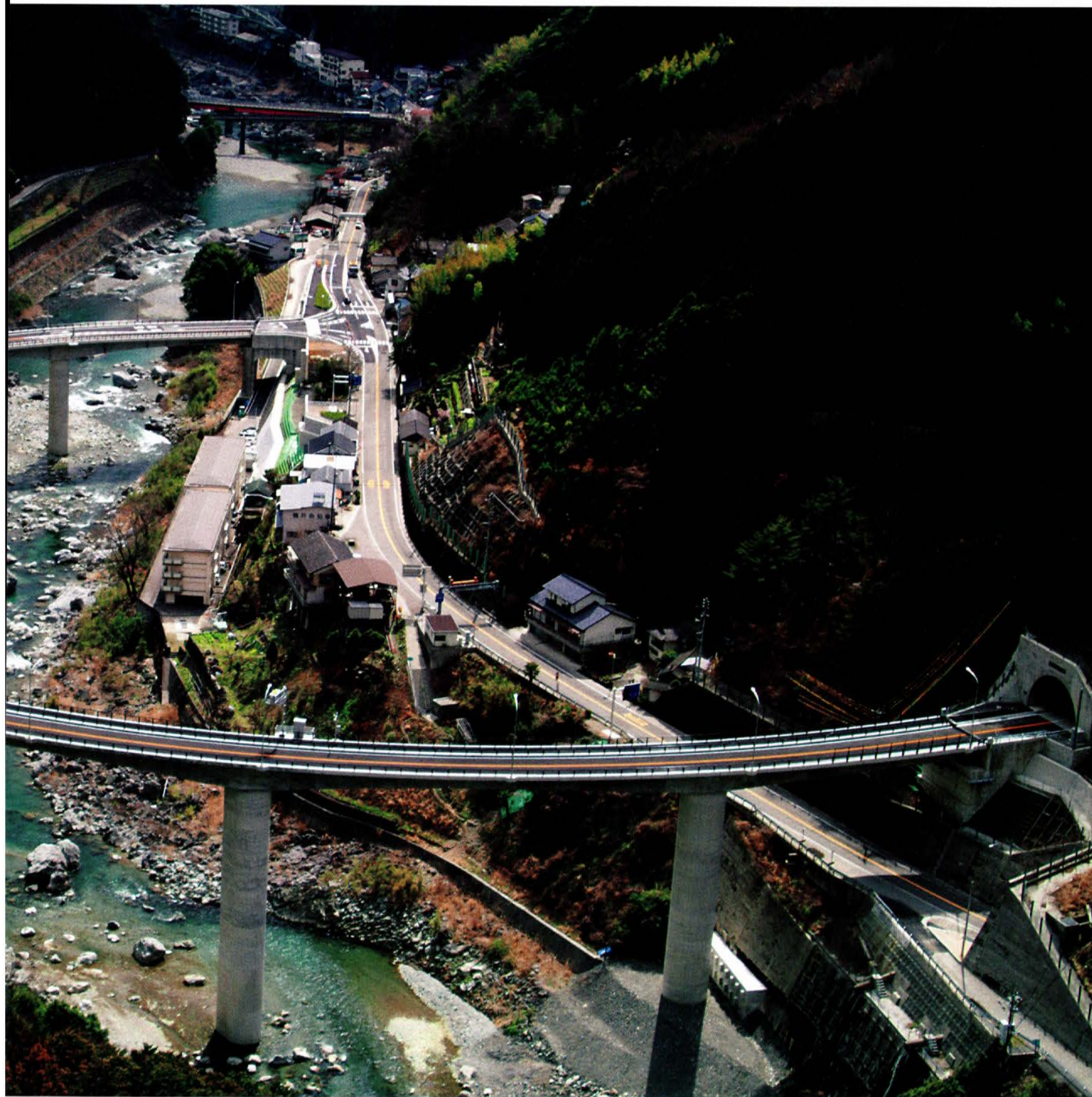
国道440号の起点両岸をつなぐループ橋
