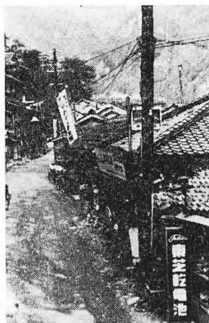
国道改修前の落出中組附近
