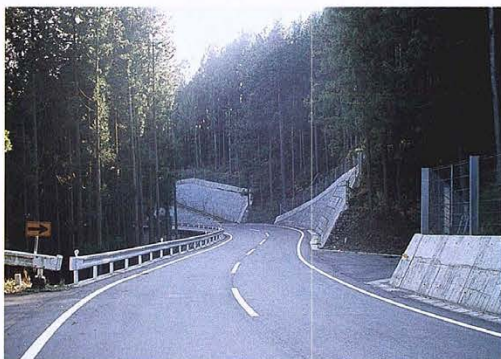
地域の生活道として改良が進む (一) 美川川内線
