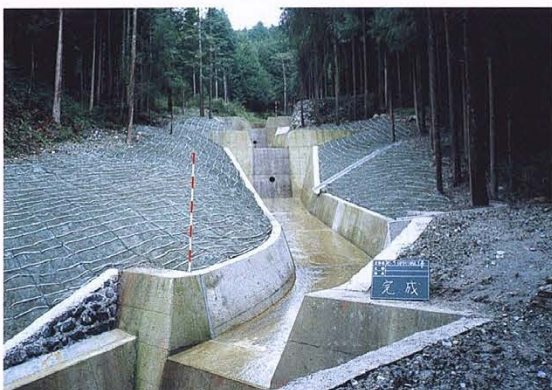
地すべり対策事業で実施された床固工及び流路工 (置俵地区)
