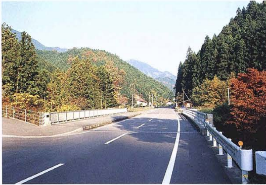
平成14年2月に供用開始した東川バイパス (大宮橋から中村方面を望む)
