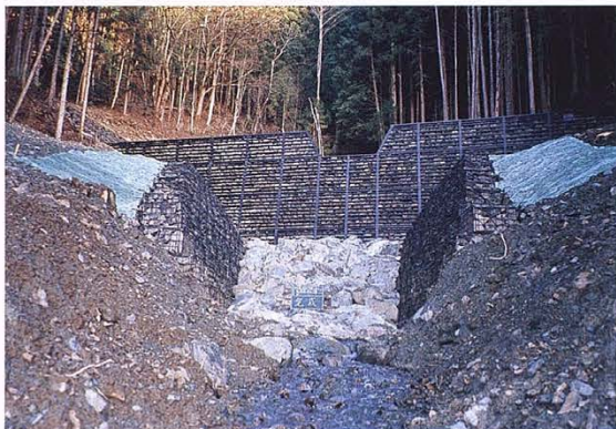
復旧治山事業で実施された鋼製谷止工 (露ヶ谷地区)
