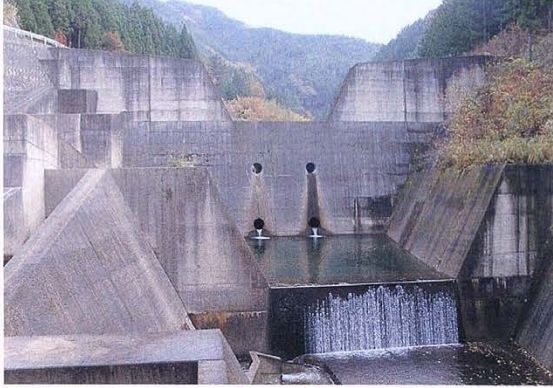
コンクリートダム本堤・副堤・魚道（前川）
