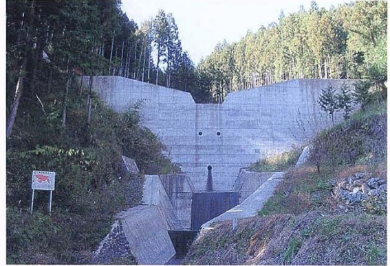
コンクリートダム（清水谷川）
