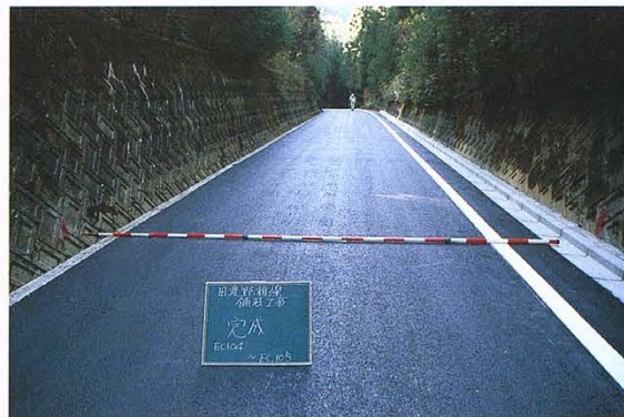
農林漁業用揮発油税財源身替林道整備事業で舗装整備が進む田渡野瀬線（上黒岩）
