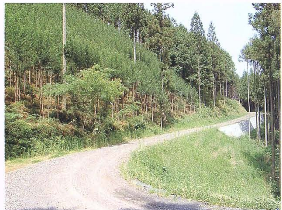
下組線 (大川) 幅員改良による大型車両の通行が可能となった
