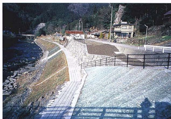
上黒岩岩陰遺跡前の整備された右岸護岸工 (上黒岩)
