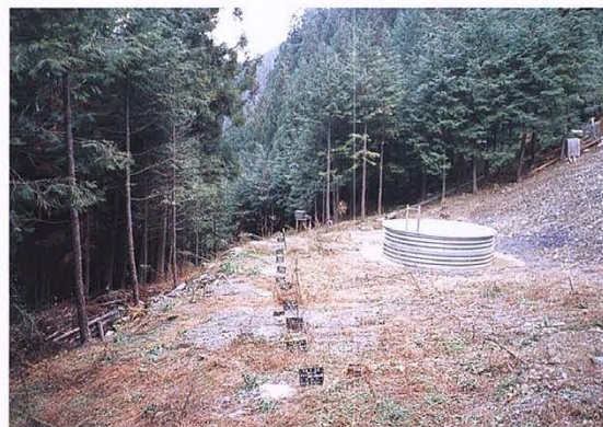
地すべり対策事業で実施された集水井及び抑止杭 (アヲツエ地区)
