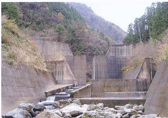
スリットダム本堤・副堤・魚道（信木川）
