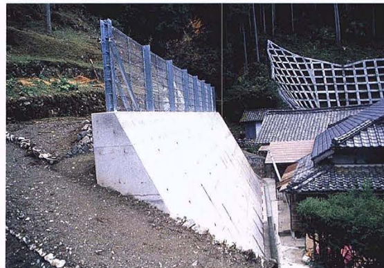
予防治山事業で実施された落石防止工 (田渡野瀬地区)
