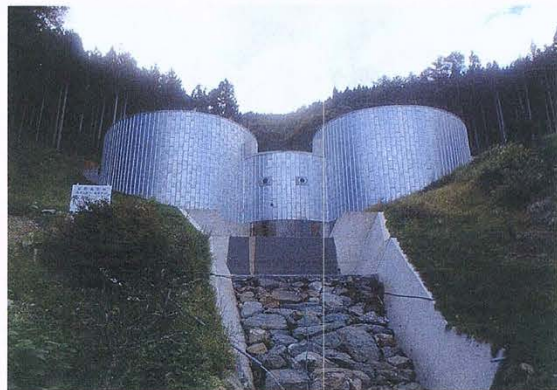
四国で初めて施工されたセルダム（惣津山谷川）
