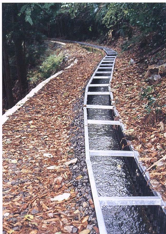
本組第二地すべり地区対策
