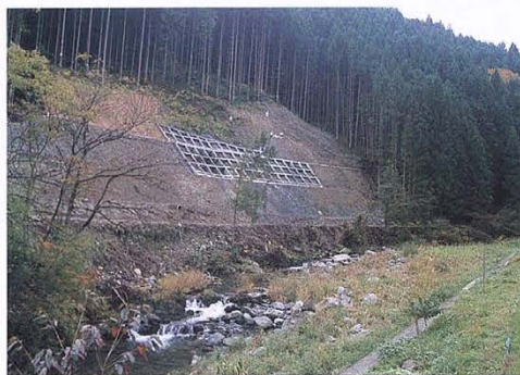
大川地区集落道工事中
