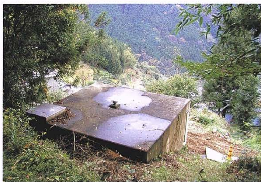
防火水槽釣井地区
