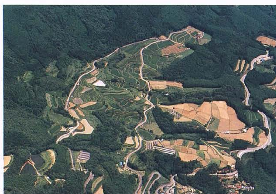
大谷地区ほ場整備 着工前
