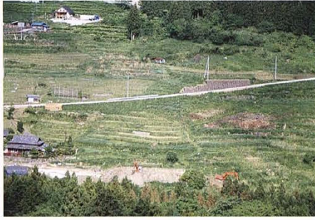
棚田事業沢渡地区ほ場整備 着工前
