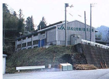
茶業センター 平成15年3月竣工
