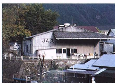
醸造加工施設 平成4年3月完成
