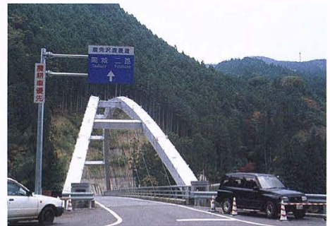
沢渡地区農免農道竣工
