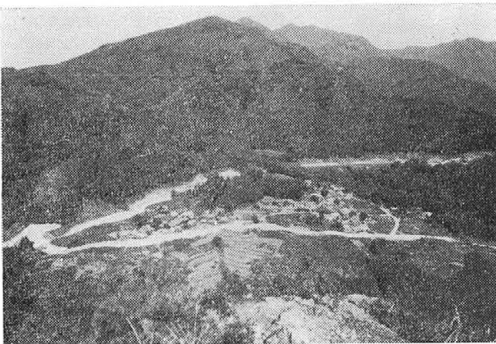
県営による過疎代行林道トロメキ・稲村線開設状況
