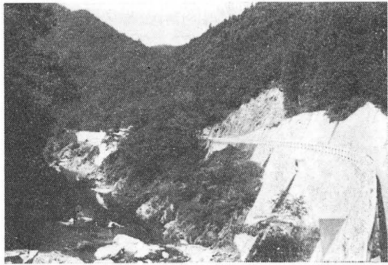
(特一) で改良された面河村境近くの(主) 西条久万線
