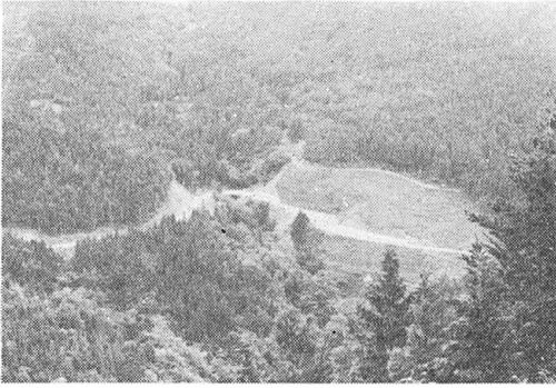
大谷線開設状況（民有林林道）
