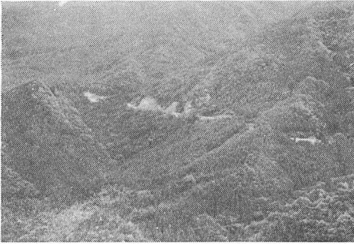
県営による広域基幹林道西谷日野浦線開設状況
