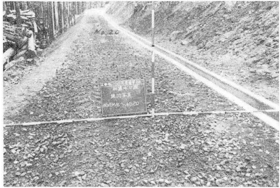
水口線開設の状況（県単林道）
