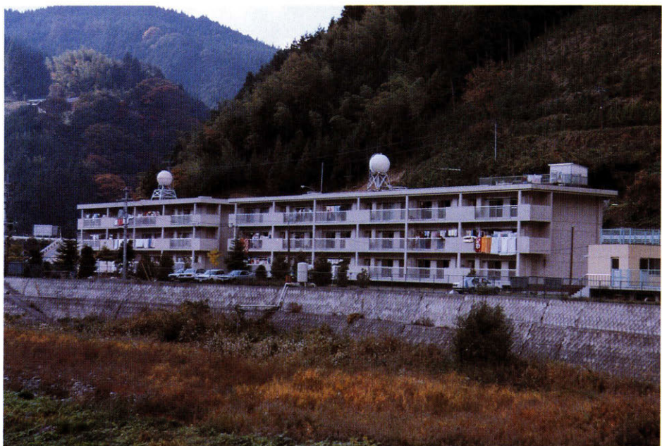
公営住宅団地
