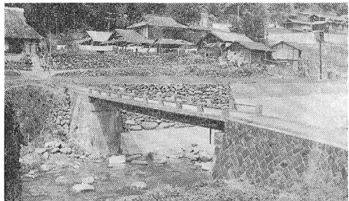
下土井橋災害復旧工事
