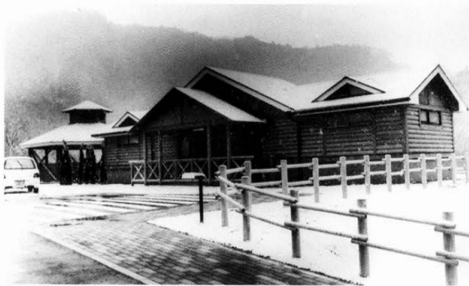
雪深い「ふるさとの駅」に完成したハーフログ造りの豪華トイレ
