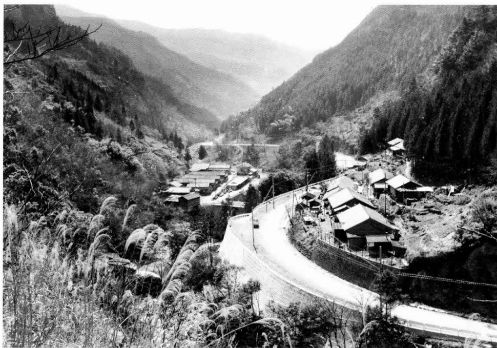
昭和50年、自然保護のため閉鎖となった松山営林署面河製品事業所
