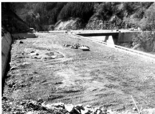
面河溪入り口付近に完成した駐車場
