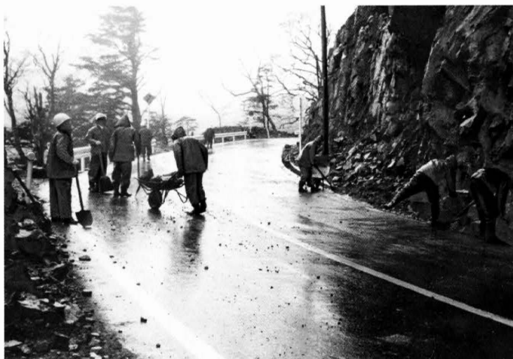
再開を目前に整備されるスカイライン(長尾尾根展望台の上手付近)
