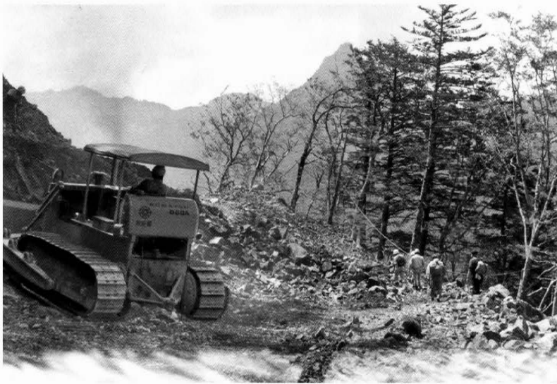
石鎚山を目の前に急ピッチに工事がすすむ石鎚スカイライン(土小屋から?)の地点で
