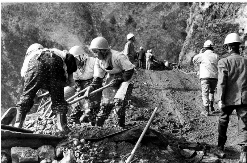
土止めのためのコンクリート打ちや石積み工事もいまたけなわ
