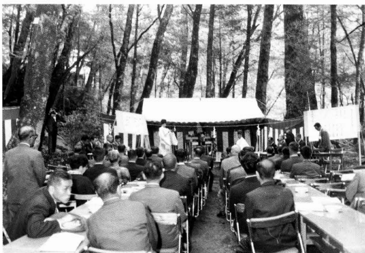
「国民の森」の起工式(面河溪の鶴ヶ背橋)
