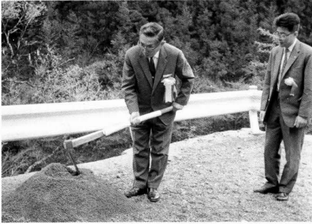
石鎚スカイラインの起点予定地でくわ入れする久松知事
