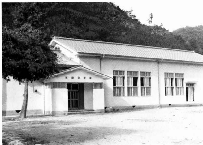
完成の城山公民館
