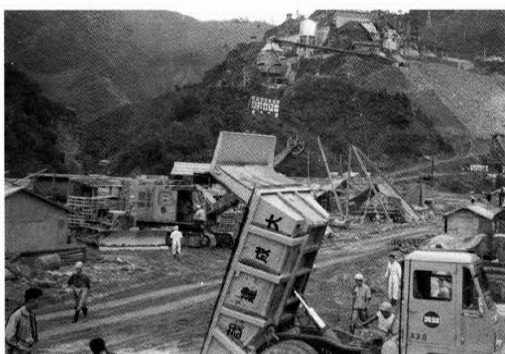
機械設備工事が完了したダム建設現場と採石山
