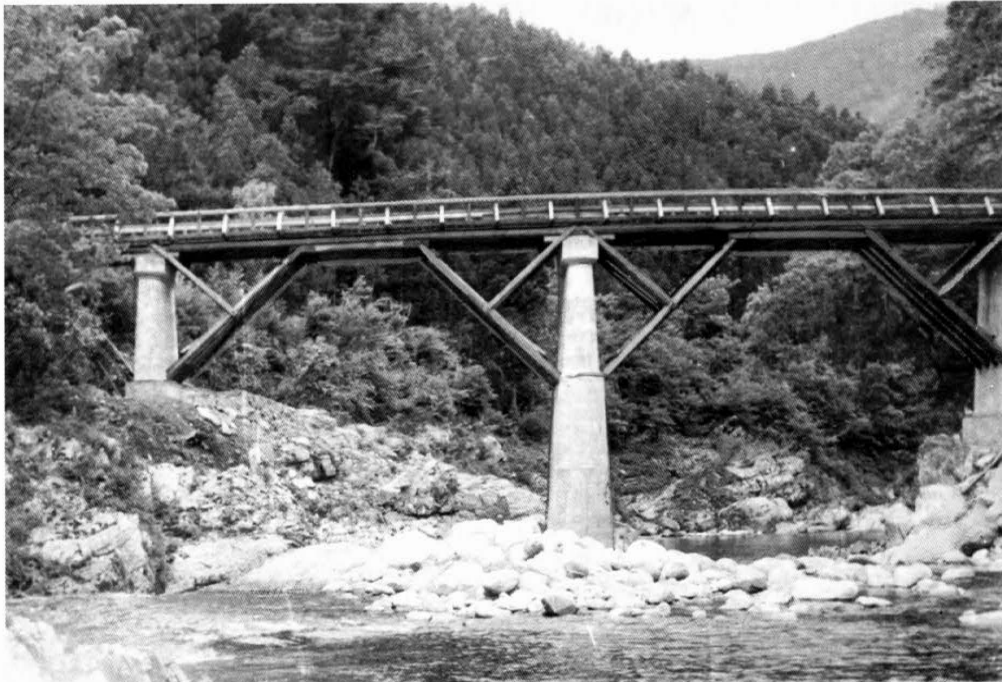
完成した川の子橋
