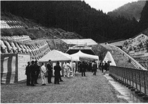
三坂トンネル
