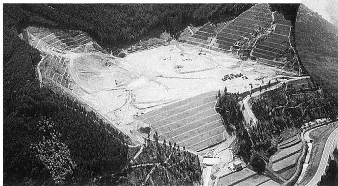
木材加工施設用地造成工事 施工中（H10.10）
