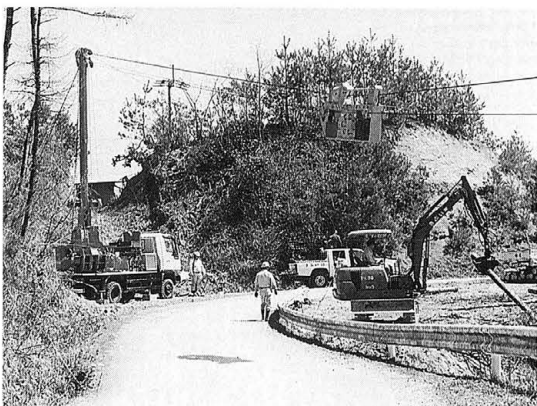
タワーヤードによる集材（柴木山）（H10.4）
