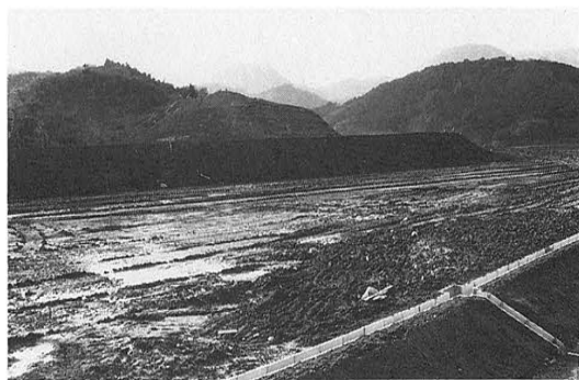
ブルドーザーによる開田作業
