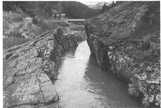
仰西渠の明渠
