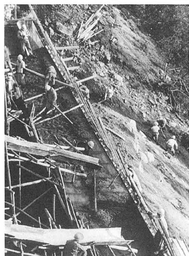
33号線改修工事
