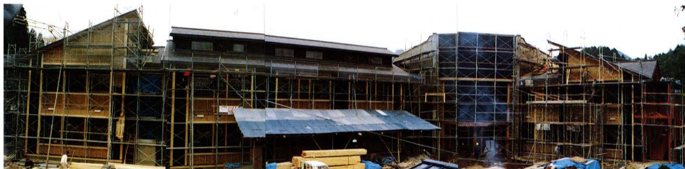
木造校舎建築風景 (畑野川小学校)
