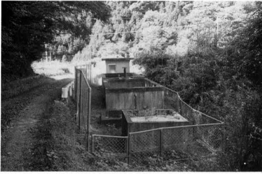
下直瀬簡易水道浄水場(昭和51年)
