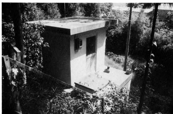
久万簡易水道日ノ地ポンプ室 (昭和54年)
