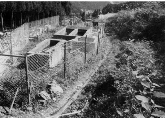
栄谷水道浄水場(昭和55年)
