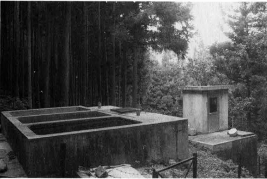
橋詰簡易水道浄水場(昭和36年)
