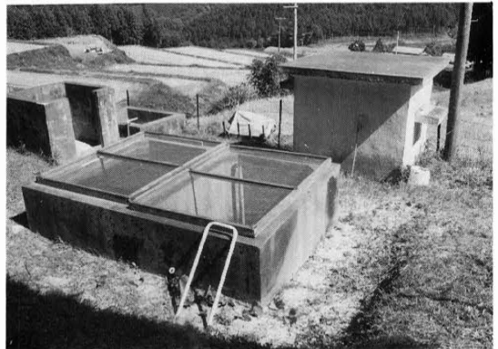
槇の川水道浄水場(昭和39年)
