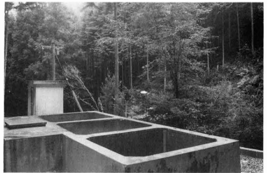
中村簡易水道浄水場(昭和36年)
