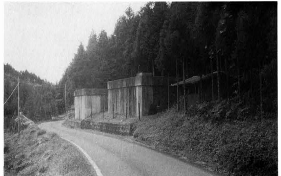
畑野川簡易水道遅越配水池 (昭和44年度)
