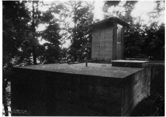
中条水道浄水場(昭和37年)
