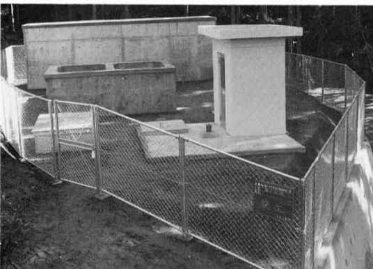
縦ノ木水道浄水場(昭和61年)
