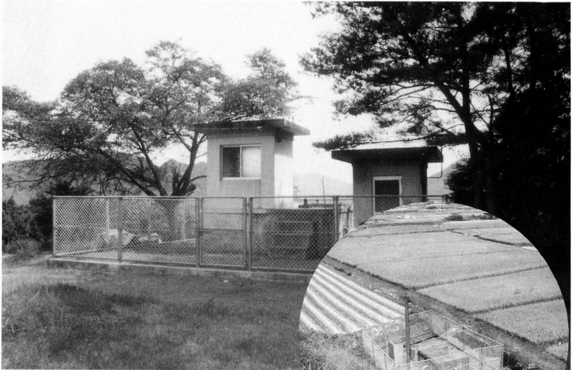
畑野川簡易水道千本配水池 " 河合水源池(湧水) (昭和52年)
