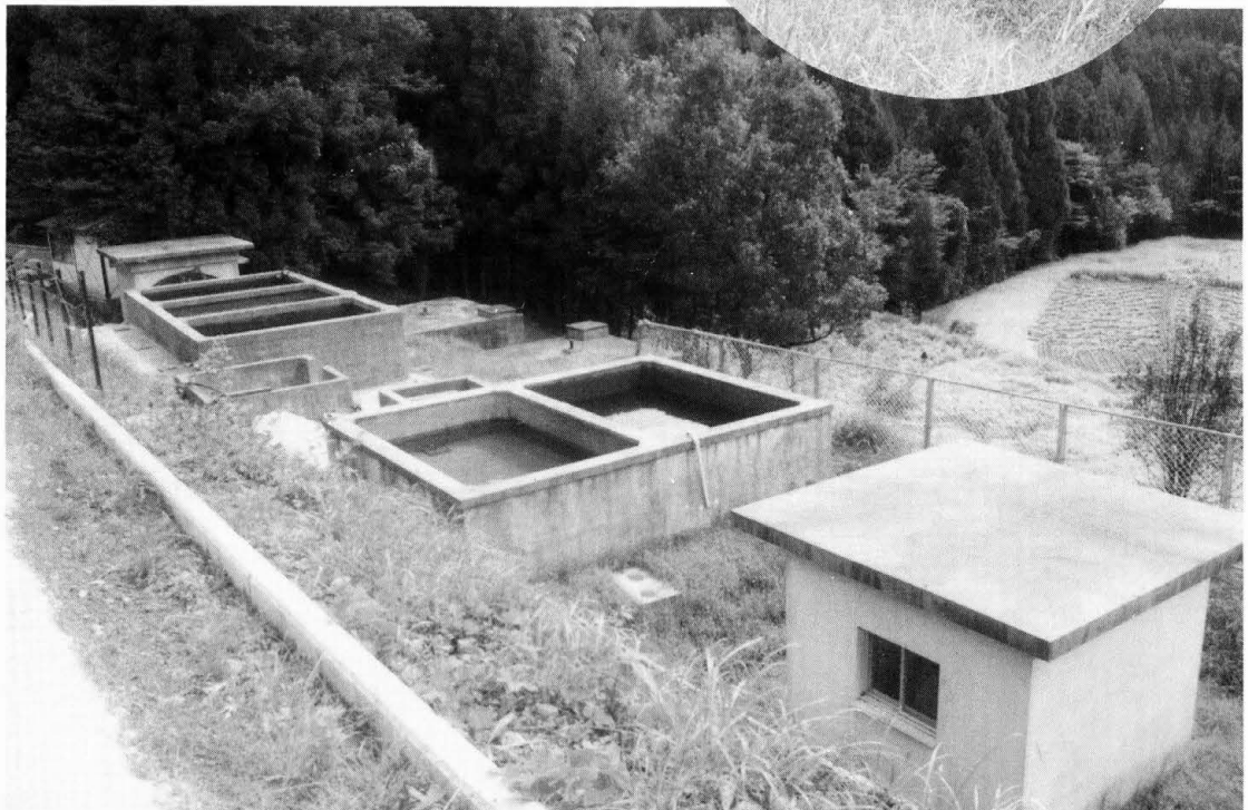
上直瀬簡易水道浄水場(昭和49年度)
