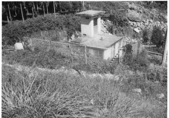
栄谷水道配水池(昭和55年)
