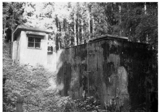
永久水道浄水場(昭和41年)
