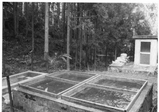
徳好水道浄水場(昭和41年) 災害復旧工事(昭和51年)
