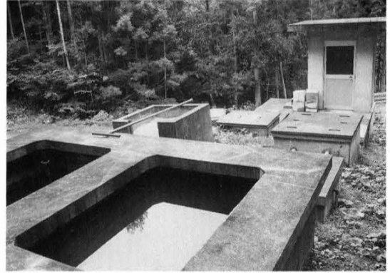
若宮水道浄水場(昭和52年)
