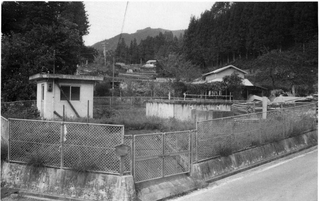
森田宮成簡易水道浄水道(昭和51年)
