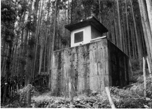
西の川水道浄水場(昭和45年)
