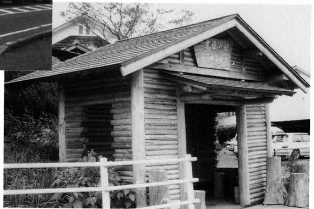
間伐材を利用した停留所
