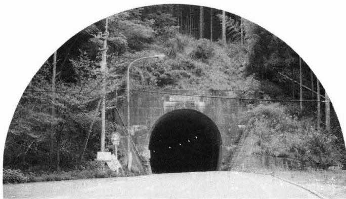
主要地方道 西条・久万線に住民待望の隧道開通
