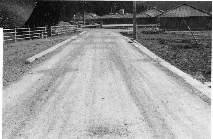
施工後 歩道も同時施工
