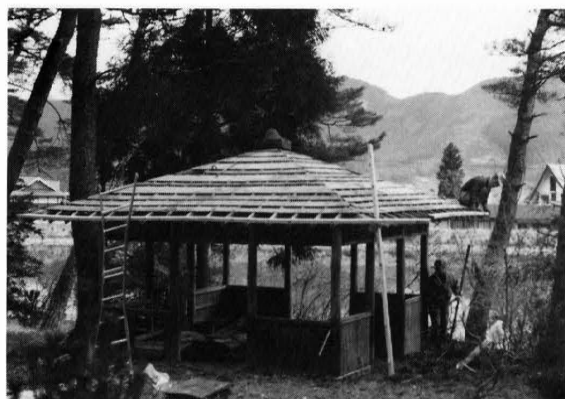
古い休憩所の修繕
