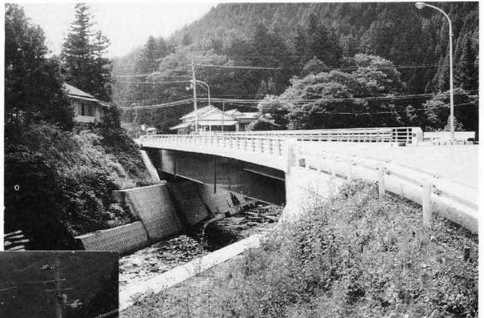
380号線 露峰工区に6本の橋が架設 最大の橋(大元橋)L=53 m S.63.
