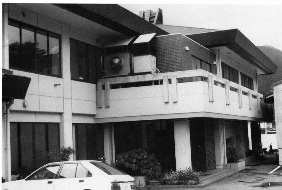
昭和58、59年度 直瀬住民センター 1,008.25㎡
