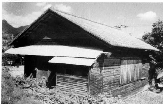
上田集会所 改修前
