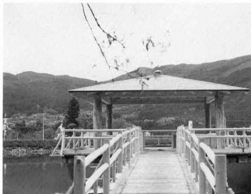
(昭和52年)新設になった水上休憩所
