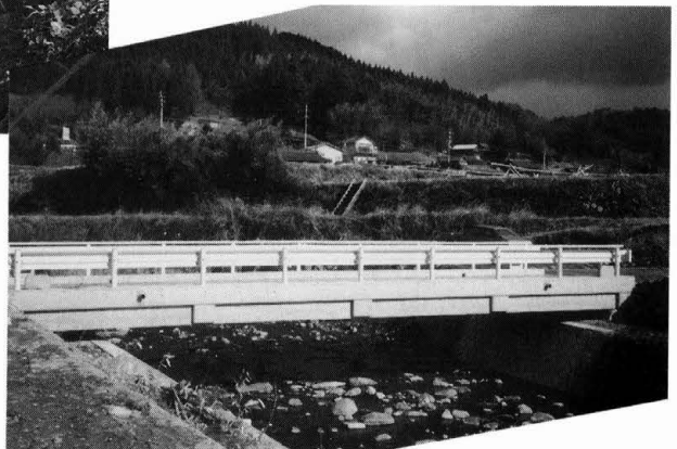
施工後 完成したP.C.橋 L=17m S.62年
