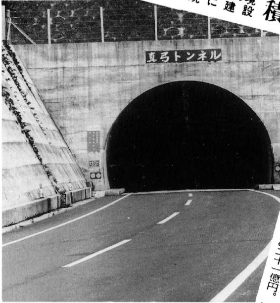
完成した新しい真弓隧道 S.63.4.5.
