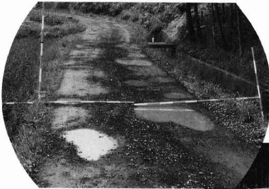
施工前 離合も出来ない狭い道
