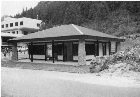
古岩屋 休憩所、食堂
