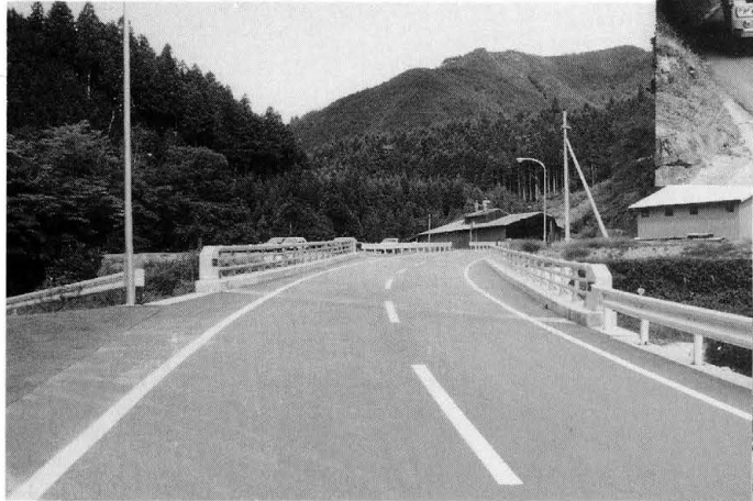
改良され架け替された新葛城橋附近
