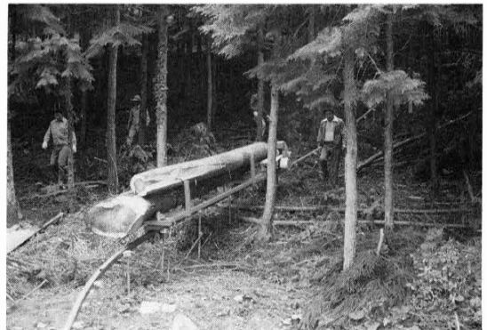
○ モノレールによる木材の搬出
