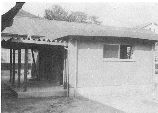
直瀬中学校便所 (昭和52年8月31日)
