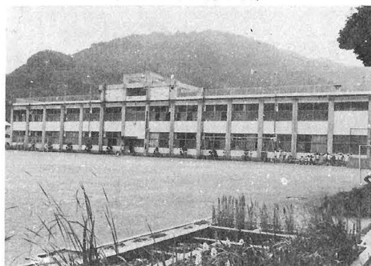
久万小学校本館
