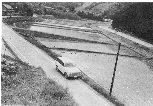
橋詰地区完成（52年）
