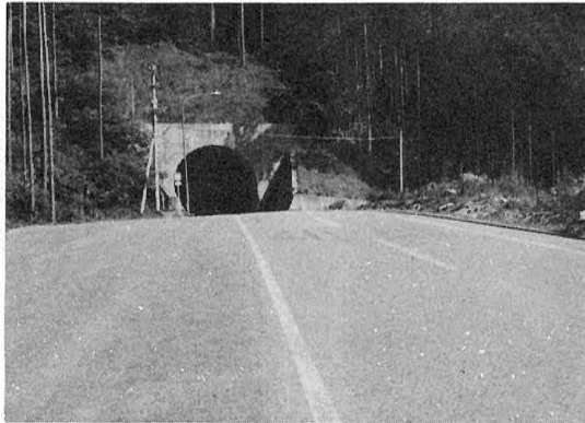
峠御堂隧道附近の現況
