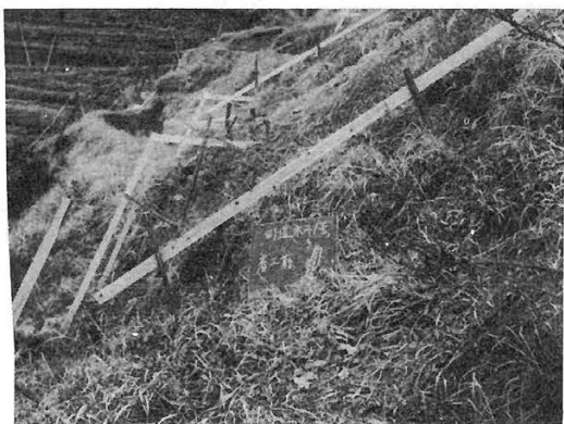
町道永子1号線復旧前
