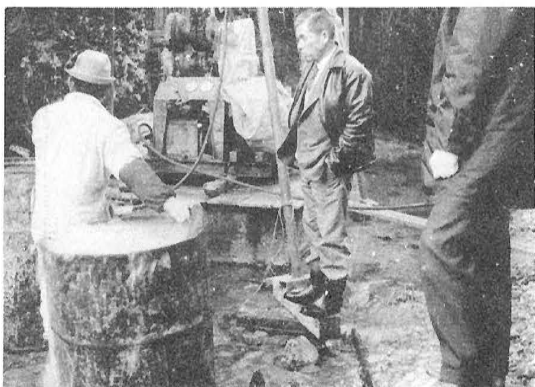
鉾泉ボーリング工事着々と進み鉾泉涌出濃くなる (47 .9)
