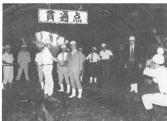
峰越林道梅ヶ谷、永子線のトンネルが貫通
