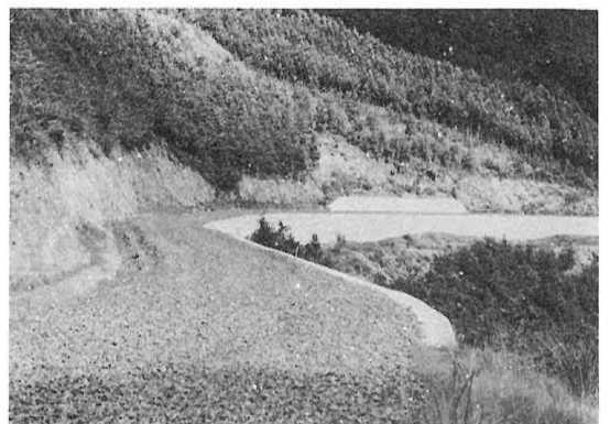
第二次林業構造改善事業 菅生宮ノ前線 (53年12月)
