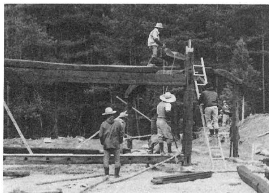
ふるさと村に移築中の本家 家の中心である大黒柱に牛上げ作業
