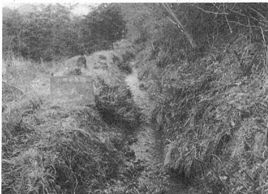
直瀬，乙井手水路着工前（53年）
