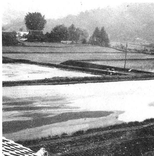
第三工区（仲組）完成
