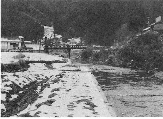
父の川（橋詰地区）改修前
