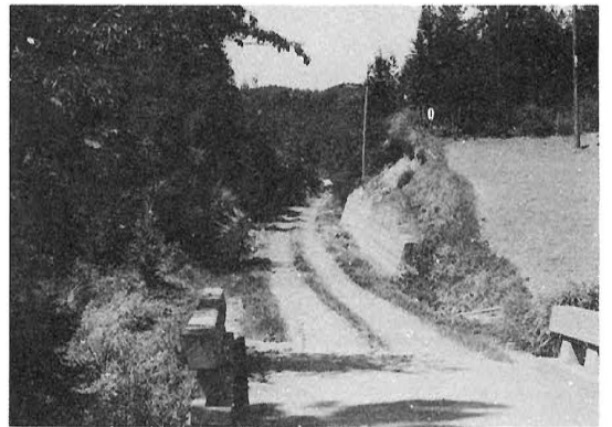
第一次林業構造改善追加事業 西ノ川線 (48年3月)
