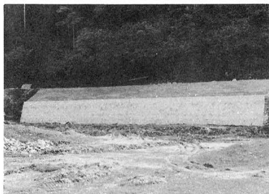
上厚線復旧後 (51年)
