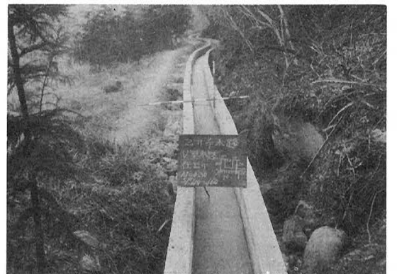
乙井手水路，完成後
