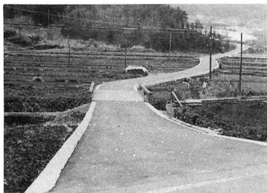
父の川線舗装完成 (52年)
