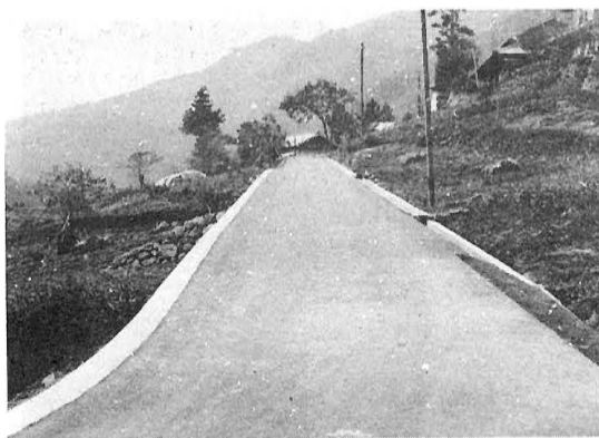
露峰, 中村線舗装完成 (52年)
