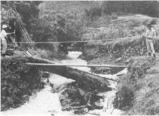
上畑野川，西之浦頭首工復旧前
