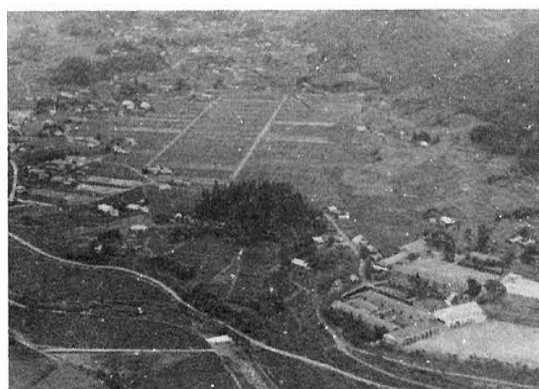
第三工区（完成）
