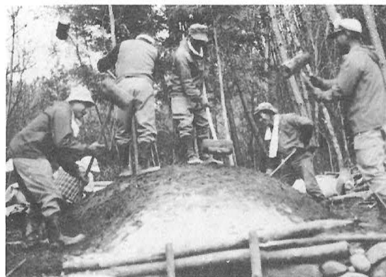
炭がまの天井上げ、元気よく 槌でかためていく
