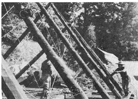
本家の屋根合掌の解体作業
