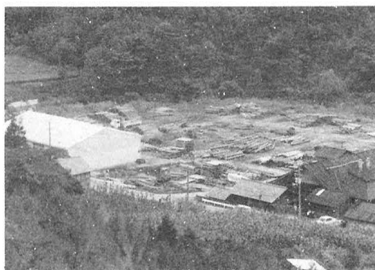
拡張になった支所工場及機械保管倉庫
