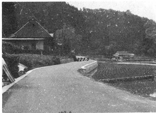
森田線舗装完成 (52年)
