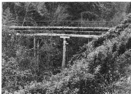
下直瀬古宮橋着工前
