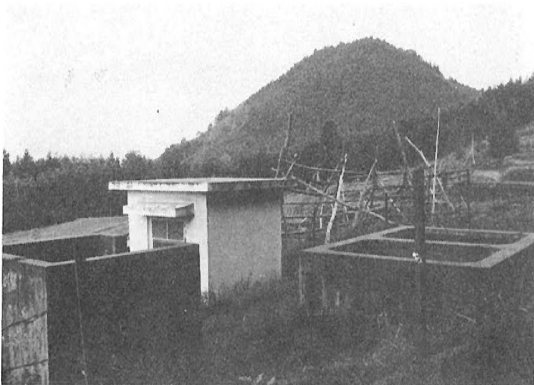
横ノ川水道浄水場 (昭39)
