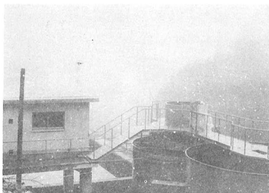
久万簡易水道急速ろ過装置 (昭46)
