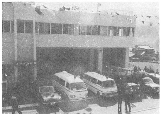
昭53.4.1上浮穴消防署落成
