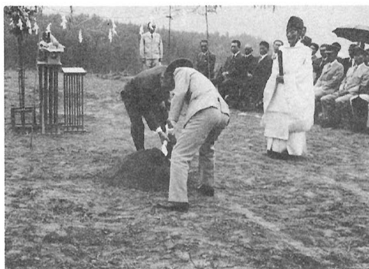
「エイッ、ヤッ」工事の安全を祈念して (久万公園起工式，52年 9月)
