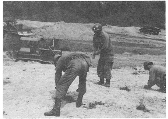
久万公園造成現場の爆破作業 (昭和52年10月)
