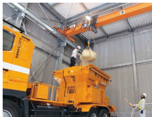
凍結防止剤の積み込み訓練
