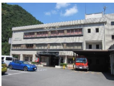
【美川】美川農村環境改善センター
