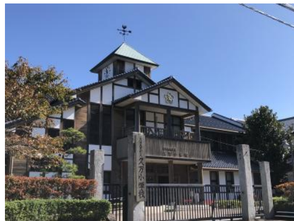
久万小学校 (木造建築)
