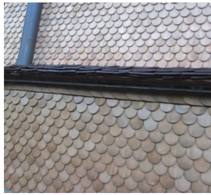
伝統的な「こけら葺き」工法
