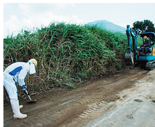
一般道の土砂撤去作業(大洲市)
