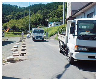
住宅街、一般道の側溝清掃(大洲市)
