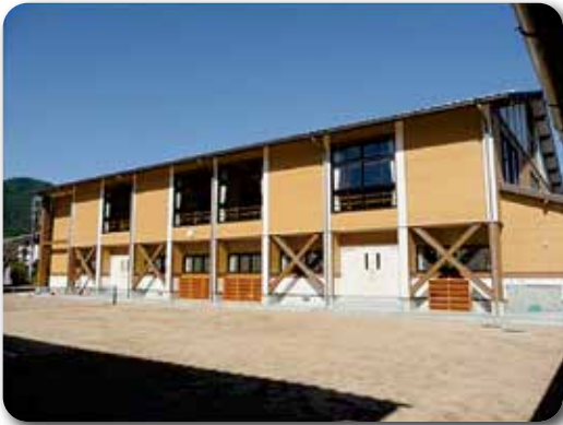
木造で新設された上浮穴高校体育館
