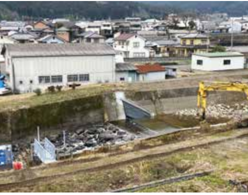
和田ノ窪の頭首工整備工事
