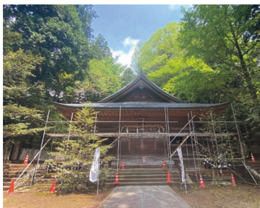
拝殿の工事の様子
