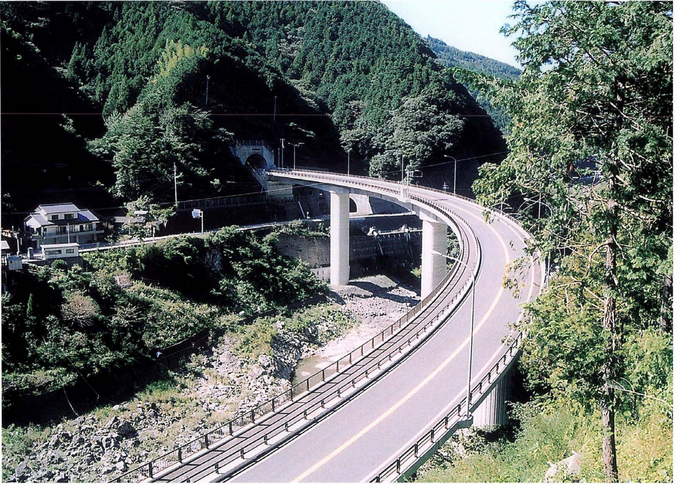
ループ橋 (落出)
