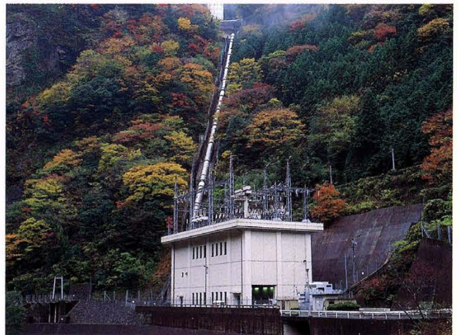
第5黒川発電所(赤子)
