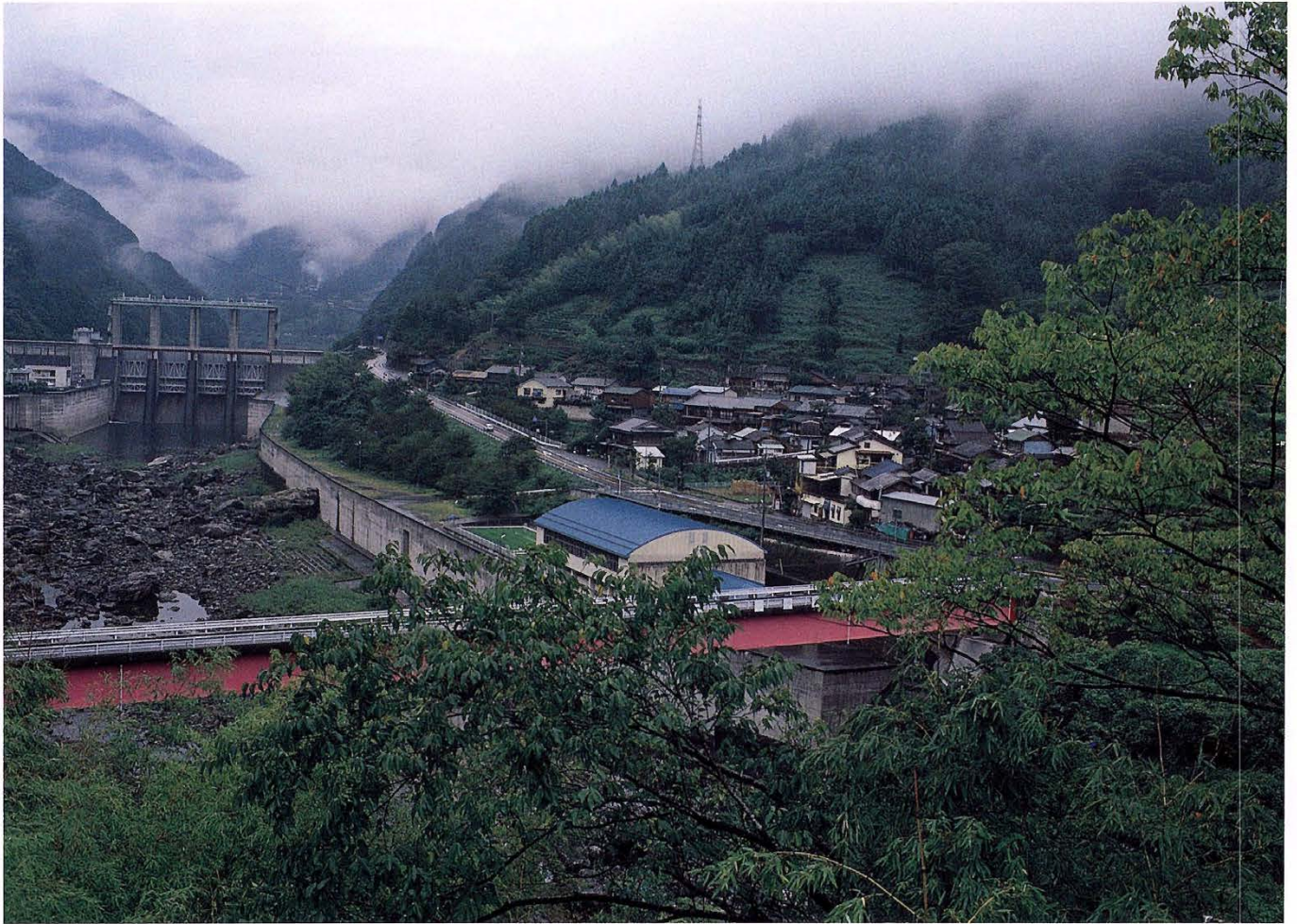
旭集落と面三ダム堰堤
