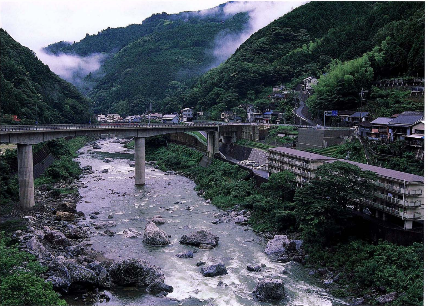
広瀬から見るループ橋起点
