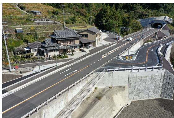
国道 33 号 (橋防災)
