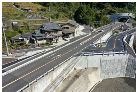
国道 33 号 (橋防災)
